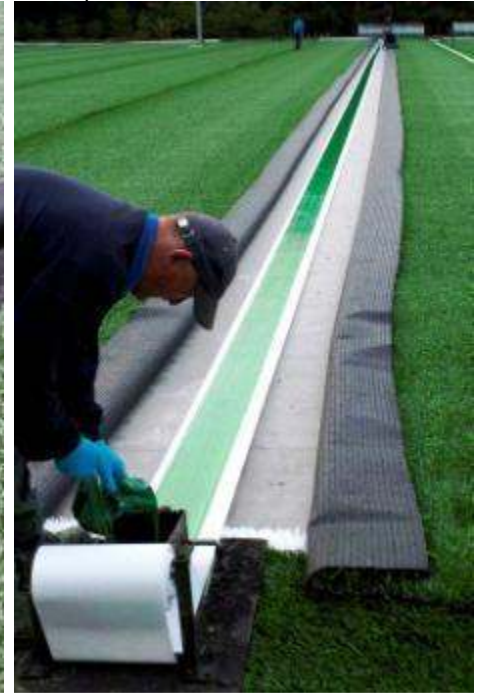
Schneiden des beschädigten Randes der Rasenrollen und Vorbereitung für das Kleben des Rasens
