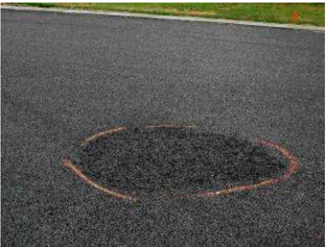
Nicht gleich kompakter Asphalt: muss ersetzt werden
