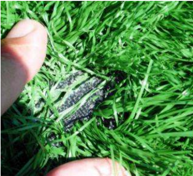
gute und annehmbare Verbindungs-Qualität
