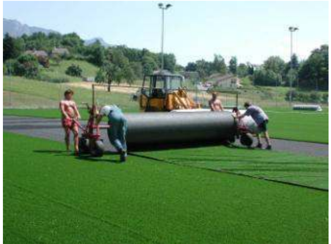
Verlegen des Rasens auf eine gebundenen Tragschicht oder einer Elastikschicht
