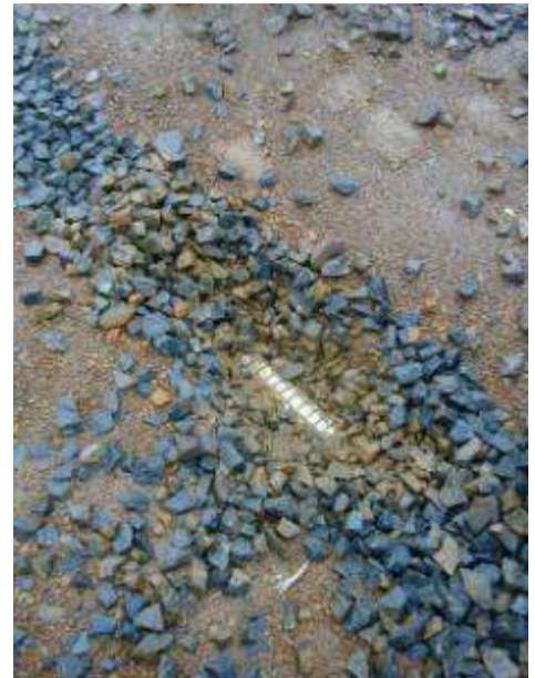
Drainagesysteme unterhalb des Unterbaus und Installation des Drainagesystems auf ein verstärktes Gewebe
