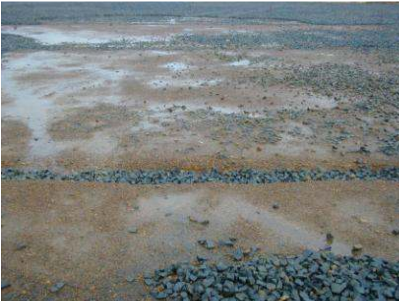
Drainagesystem eingebaut unter dem Aushubniveau
