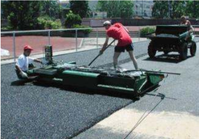
Einbau einer Elastikschicht vor Ort (in situ) auf einer Asphaltunterlage
