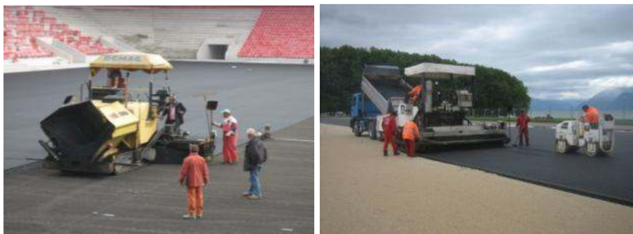
Strassenbaumaschine, die mit einer automatischen Nivellierungsvorrichtung arbeitet
