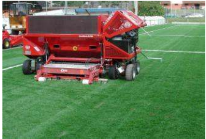
Erste Schicht mit getrocknetem Quarzsand; Einbau der Verfüllung mit Geschwindigkeit/Quantität gesteuerten Maschinen
