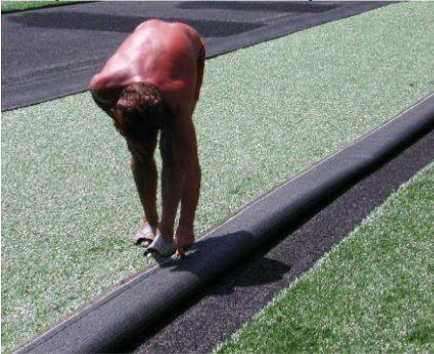
Schneiden des beschädigten Randes der Rasenrollen und Vorbereitung für das Kleben des Rasens
