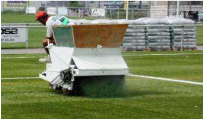
Einbau der Verfüllung mit den Maschinen, welche ursprünglich nicht für diese Art Arbeit entwickelt waren...
