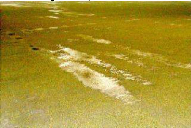
Schneeräumung mit Fräse, anschliessend Schneeschmelzen durch die Bodenheizung
