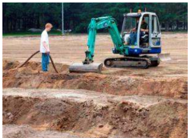
Installation eines Entwässerungssystems in einer Sandschicht und elektronisch gesteuertes Planieren
