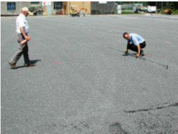
Überprüfung der Ebenheit Ebenheits- und Kompressionskontrolle
