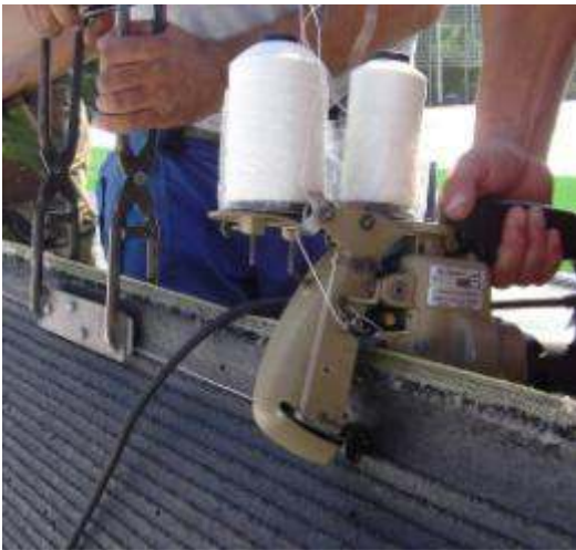
Genähte Rasenverbindung (Anm: In diesem System werden die Verbindungen genäht, aber die Markierungen werden geklebt)
