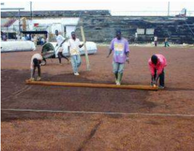
Kontrolle der Ebenheit von einem ungebundenen Unterbau mit einer improvisierten handgemachten Messlatte
