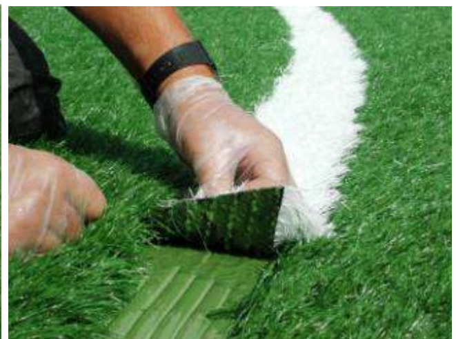
Schnitt den Rasen für die Linie Markierungen und Kleben der Verbindungen des Teppichs und der Markierungen
