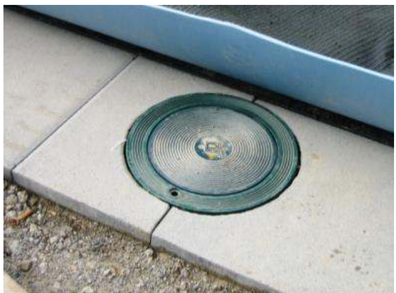
Wassersprenger ausserhalb des Spielfeldes eingebaut
