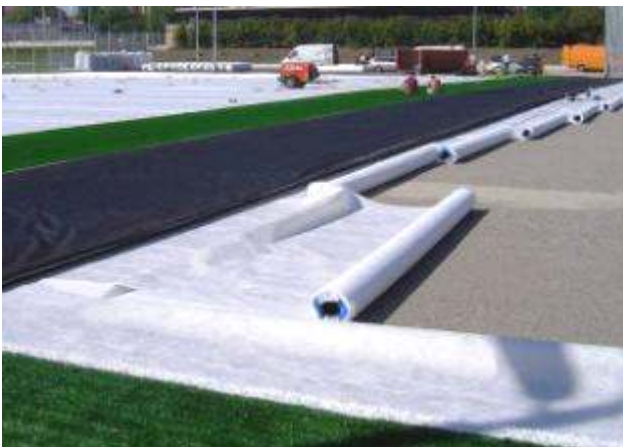
Verlegen von einem Geotextil auf ungebundener Tragschicht als Schutz für den Teppichrücken
