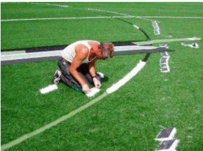
Schnitt den Rasen für die Linie Markierungen und Kleben der Verbindungen des Teppichs und der Markierungen
