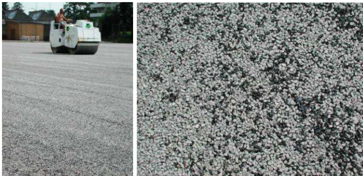
Feiner Kies stabilisiert und gebunden mit Verschnittbitumen, wasserdurchlässig
