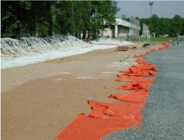
Bodenheizung unter einer unstabilisierten Unterlage
