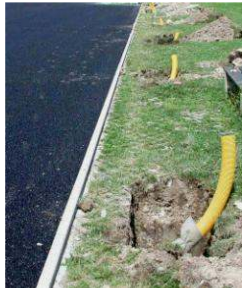
Zugang zu den Drainageleitungen
