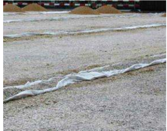
Drainagesysteme unterhalb des Unterbaus und Installation des Drainagesystems auf ein verstärktes Gewebe
