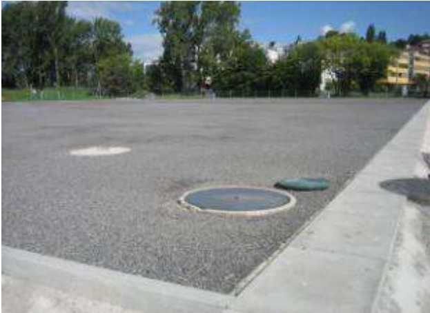
Oberflächenplanung mit feinem gebrochenem Stein
