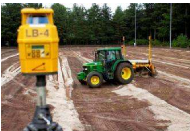
Installation eines Entwässerungssystems in einer Sandschicht und elektronisch gesteuertes Planieren
