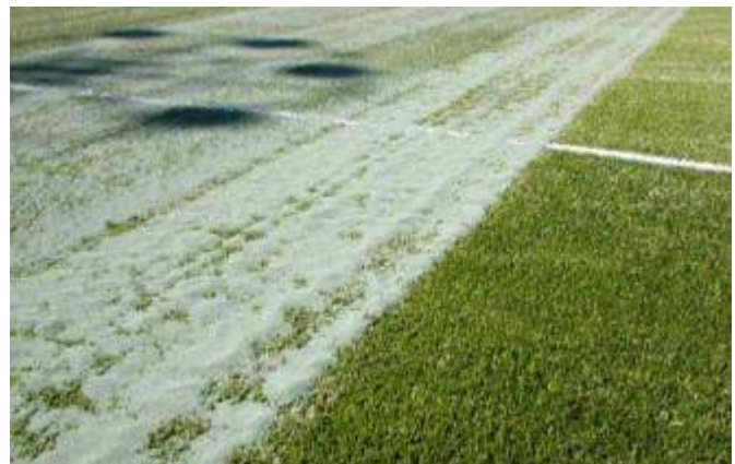
...dies führte zu unterschiedlichen Einbaustärken, welche schwierig zu kontrollieren waren. Oft wurde zu viel verfüllt, und viele Fasern blieben unter der Verfüllung begraben.
