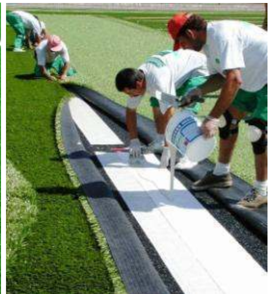
Schnitt den Rasen für die Linie Markierungen und Kleben der Verbindungen des Teppichs und der Markierungen
