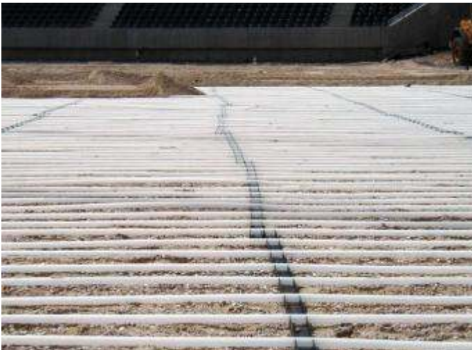
Bodenheizung eingebaut in einer Sandunterlage
