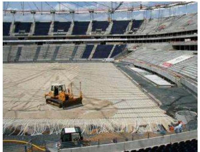
Isolierung und Bodenheizung eingebaut unterhalb einer stabilisierten Unterlage
