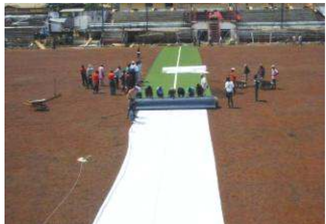
Verlegen von einem Geotextil auf ungebundener Tragschicht als Schutz für den Teppichrücken
