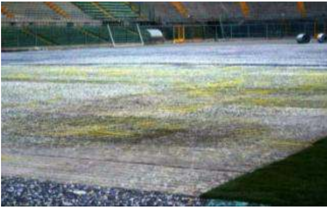
Bodenheizung eingebaut in einer Elastikschicht direkt unterhalb des Football Turf
