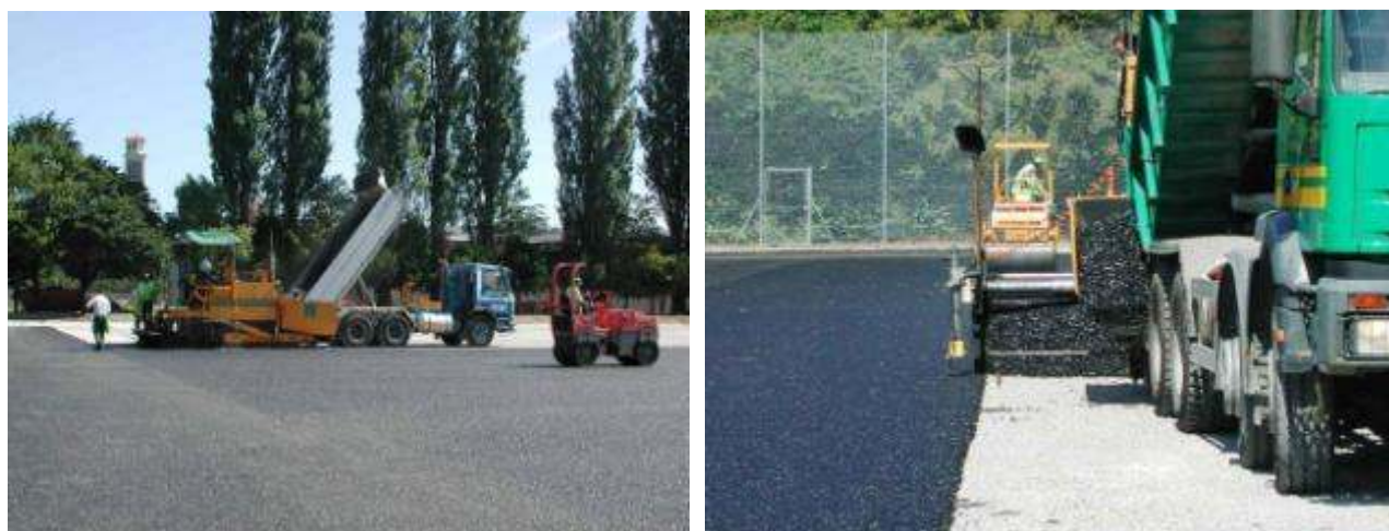
Einbau einer einlagigen, wasserdurchlässigen Asphalttschicht
