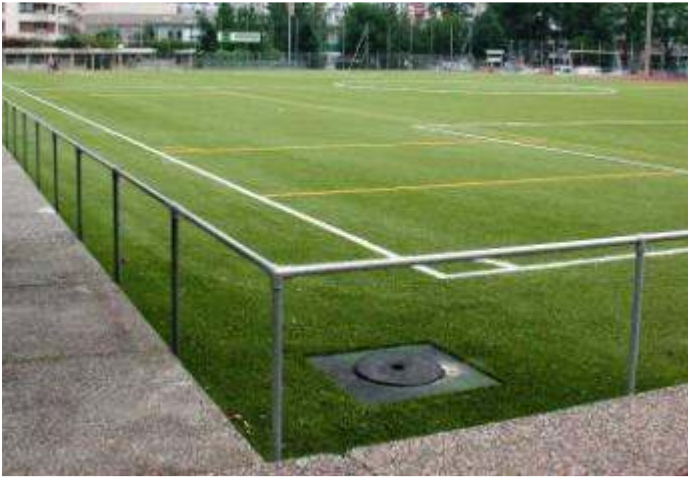
Handläufe und Spezialabdeckungen der Bewässerungsanlagen
