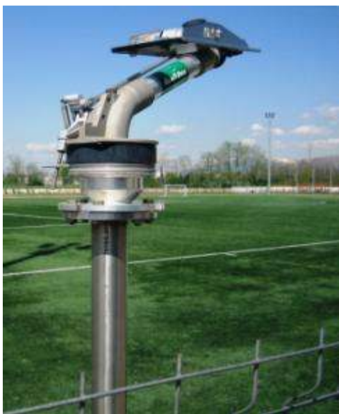
Wassersprenger ausserhalb des Spielfeldes eingebaut
