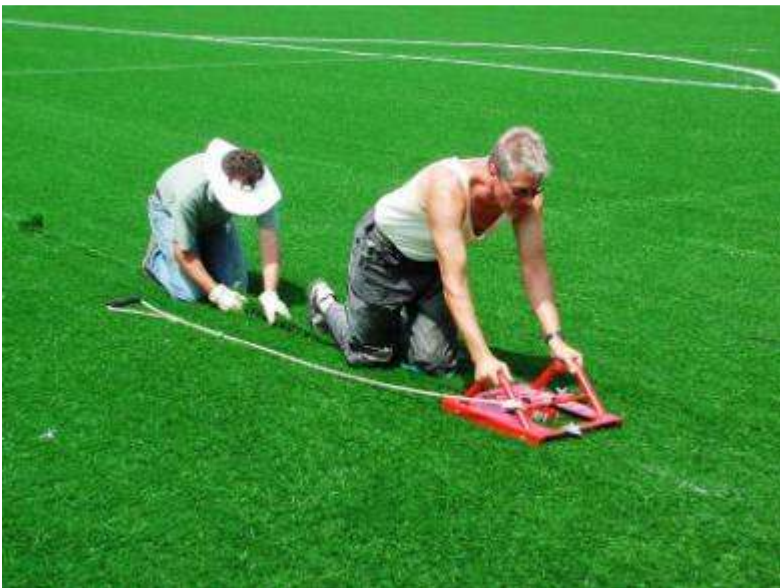
Schnitt den Rasen für die Linie Markierungen und Kleben der Verbindungen des Teppichs und der Markierungen
