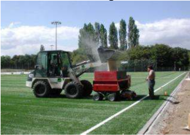
Erste Schicht mit getrocknetem Quarzsand; Einbau der Verfüllung mit Geschwindigkeit/Quantität gesteuerten Maschinen
