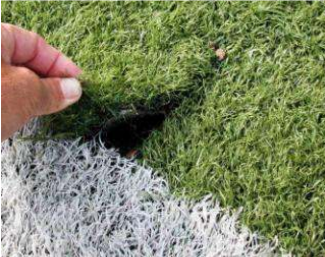
Geöffnete Verbindungen sind nicht annehmbar, verkürzen die Lebenszeit und sind für die Spieler gefährlich
