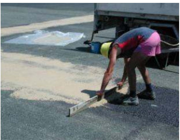
Korrektur der unebenen Asphaltsschicht
