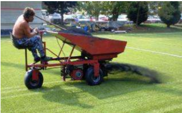
Einbau der Verfüllung mit den Maschinen, welche ursprünglich nicht für diese Art Arbeit entwickelt waren...
