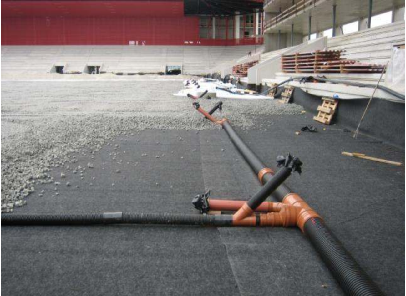
Grösse und Abstand zwischen den Drainagerohren sind abhängig von der lokalen Niederschlagsmenge
