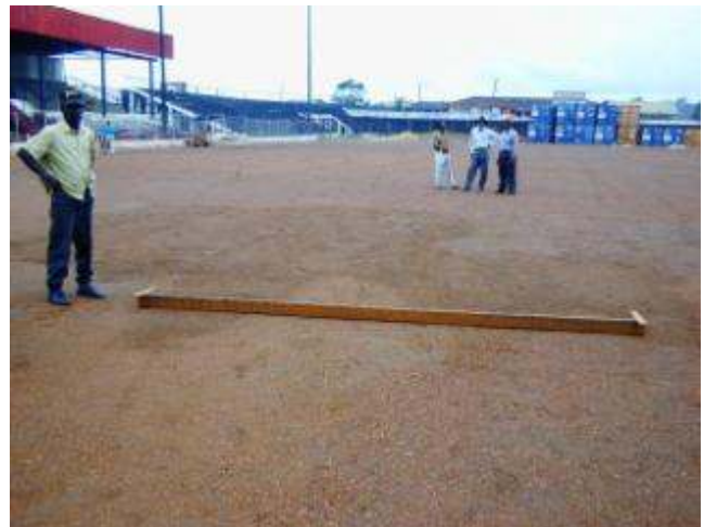
Kontrolle der Ebenheit von einem ungebundenen Unterbau mit einer improvisierten handgemachten Messlatte
