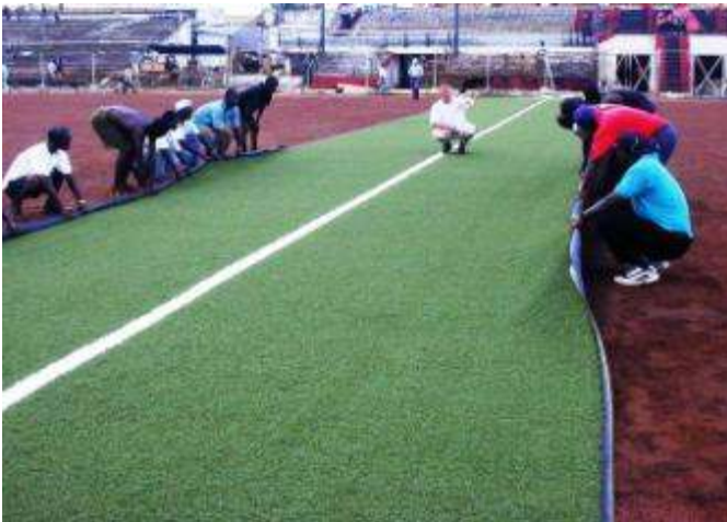
Einbau eines Football Turfs auf einer ungebundenen Tragschicht, aber auf ein verstärktes Gewebe
