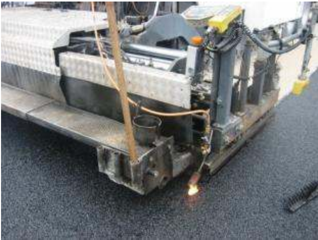
Spezielle Methode: Fugenerwärmung und Walzen zusammen bewirken eine gleichmässige Fläche
