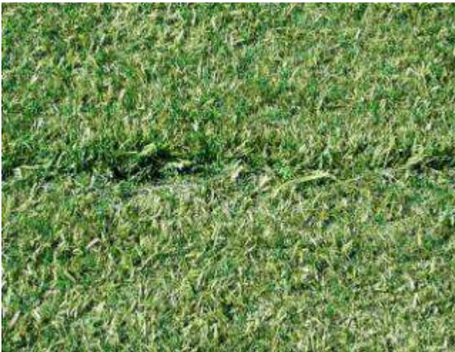
Nicht annehmbarer harter Kleber auf der Oberseite und innerhalb der Rasenfasern
