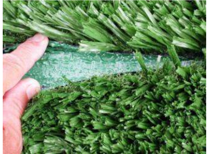
Geöffnete Verbindungen sind nicht annehmbar, verkürzen die Lebenszeit und sind für die Spieler gefährlich
