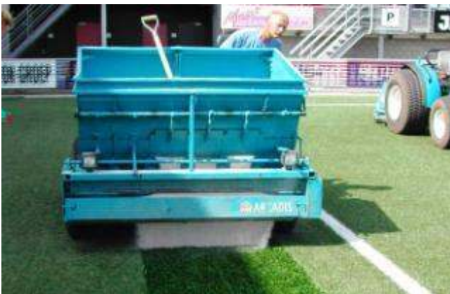
...dies führte zu unterschiedlichen Einbaustärken, welche schwierig zu kontrollieren waren. Oft wurde zu viel verfüllt, und viele Fasern blieben unter der Verfüllung begraben.
