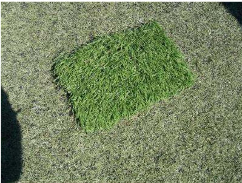
Rasenfaser nicht UV- resistent, Vergleich eines eingebauten Rasens nach 2 Jahren mit einer Original-Rasenprobe
