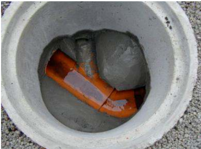
Drainage-Steuerungsschacht
