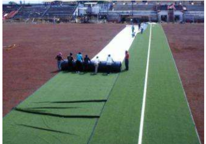
Einbau eines Football Turfs auf einer ungebundenen Tragschicht, aber auf ein verstärktes Gewebe
