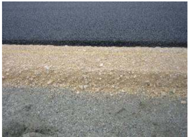
Spezielle Methode: Fugenerwärmung und Walzen zusammen bewirken eine gleichmässige Fläche
