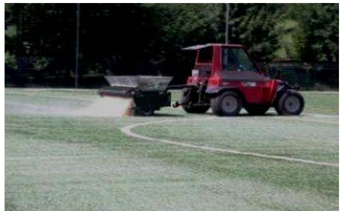
...dies führte zu unterschiedlichen Einbaustärken, welche schwierig zu kontrollieren waren. Oft wurde zu viel verfüllt, und viele Fasern blieben unter der Verfüllung begraben.
