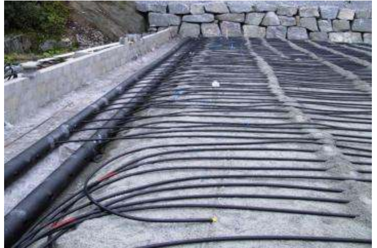
Isolierung und Bodenheizung eingebaut unterhalb einer stabilisierten Unterlage
