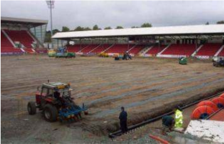
Drainagesysteme unterhalb des Unterbaus und Installation des Drainagesystems auf ein verstärktes Gewebe
